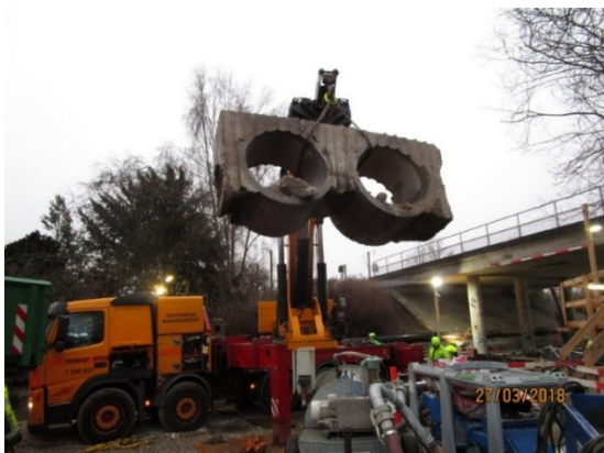
Fra anlægsarbejdet i forbindelse med Gentofterenden.
